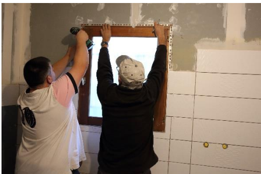
Pose du carrelage.
